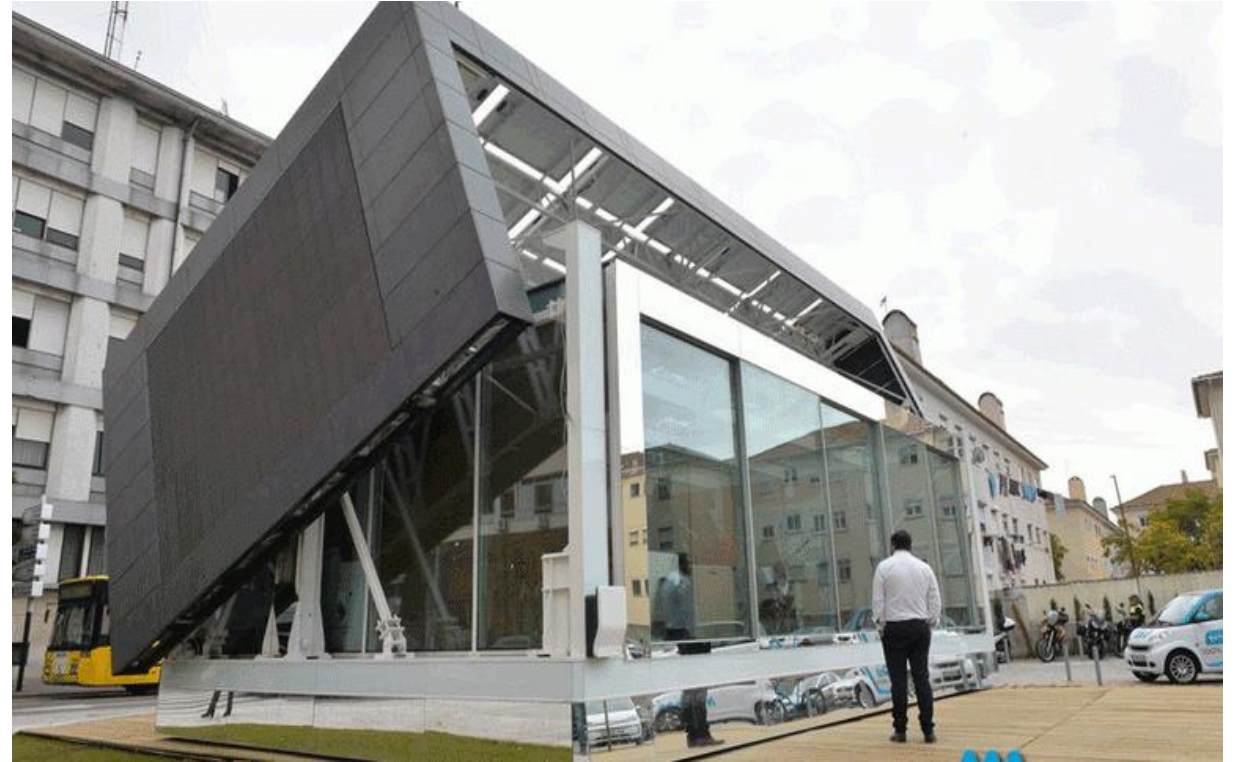
Living Lab carbono-zero de Matosinhos, Porto, Portugal - Testes e experimentos, em contexto real, de conjunto de soluções tecnológicas nas áreas da mobilidade, energia, ambiente e edifícios, com vista à criação de um bairro carbono zero.
